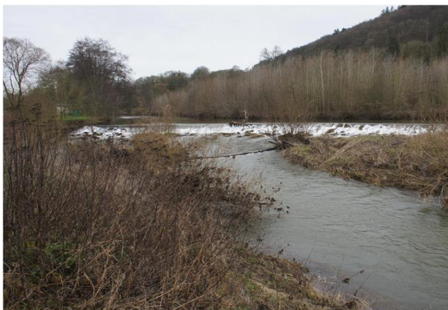
Foto gegen Fließrichtung
