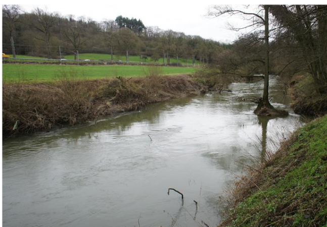
Foto gegen Fließrichtung
