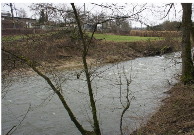
Foto gegen Fließrichtung
