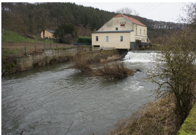
Foto gegen Fließrichtung
