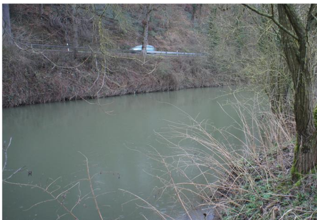
Foto gegen Fließrichtung
