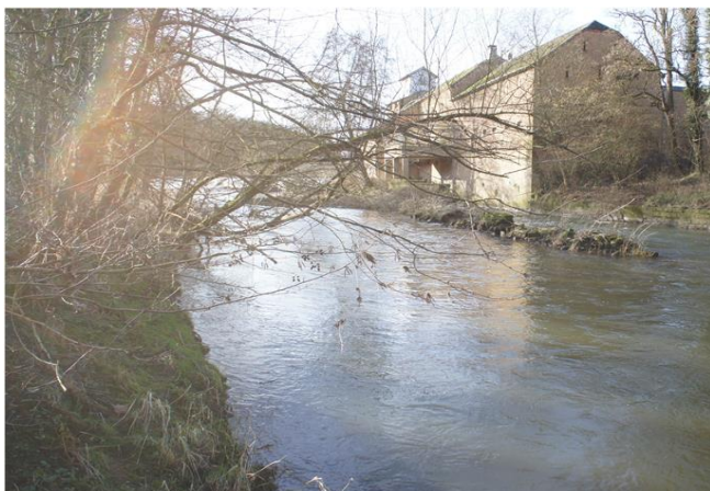
Foto gegen Fließrichtung
