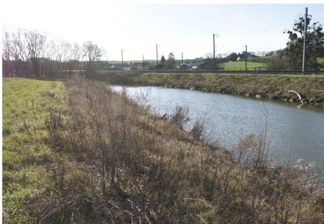
Foto gegen Fließrichtung
