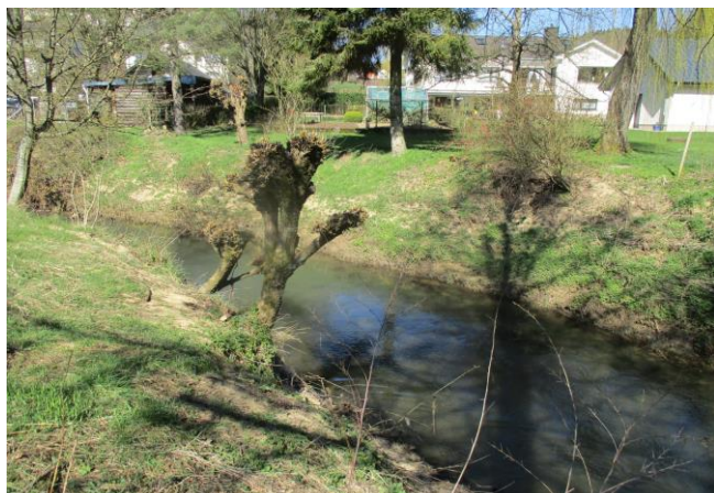
Foto gegen Fließrichtung
