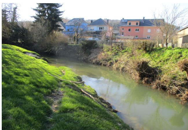
Foto gegen Fließrichtung
