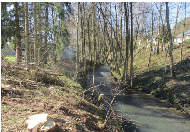
Foto gegen Fließrichtung
