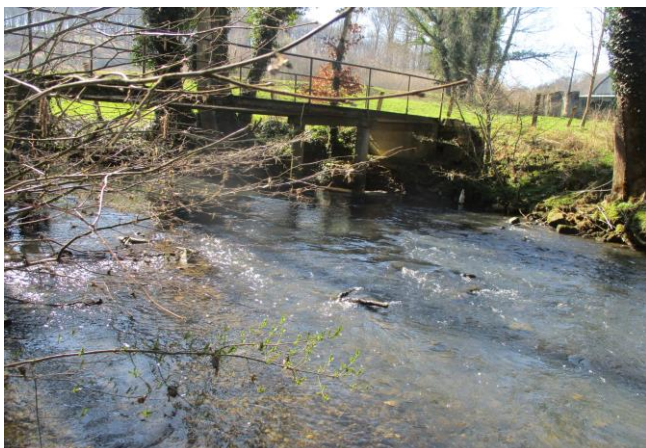
Foto gegen Fließrichtung
