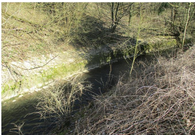
Foto gegen Fließrichtung
