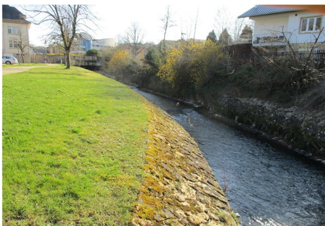
Foto gegen Fließrichtung
