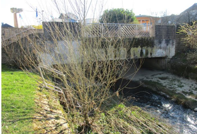
Foto gegen Fließrichtung
