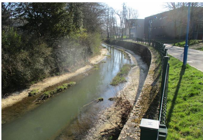
Foto gegen Fließrichtung
