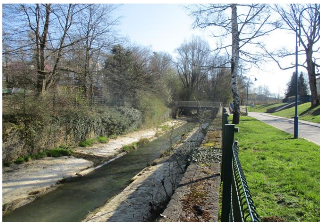
Foto gegen Fließrichtung
