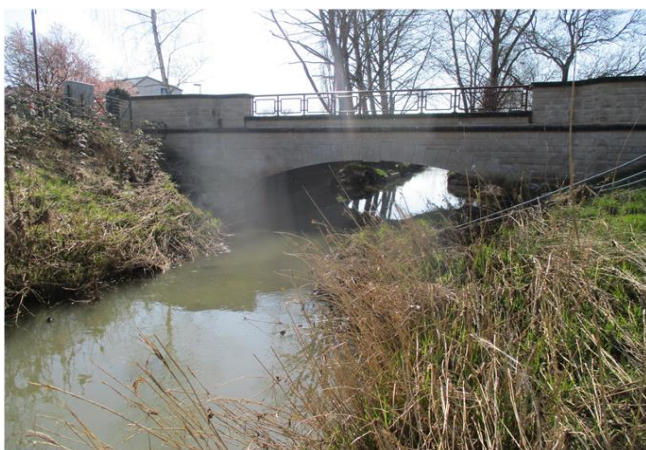
Foto gegen Fließrichtung
