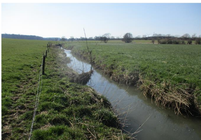
Foto gegen Fließrichtung
