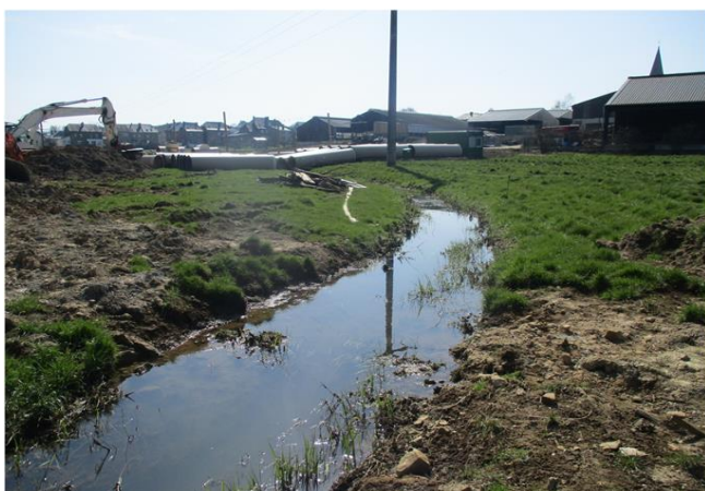
Foto gegen Fließrichtung
