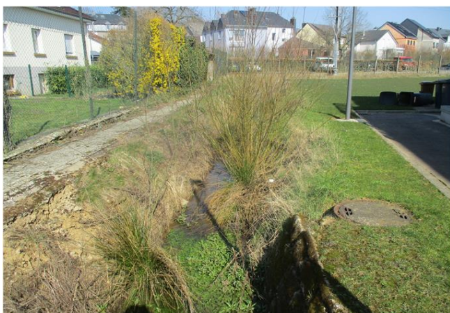
Foto gegen Fließrichtung
