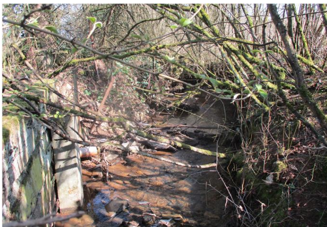
Foto gegen Fließrichtung
