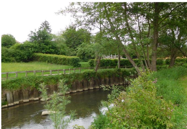
Foto gegen Fließrichtung
