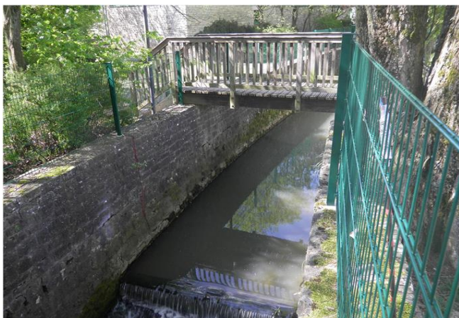
Foto gegen Fließrichtung
