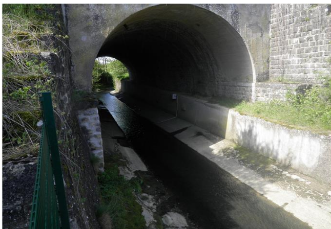
Foto gegen Fließrichtung
