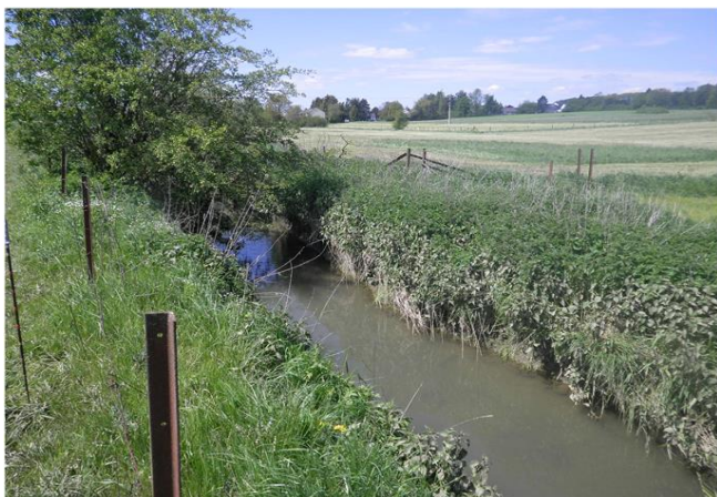
Foto gegen Fließrichtung
