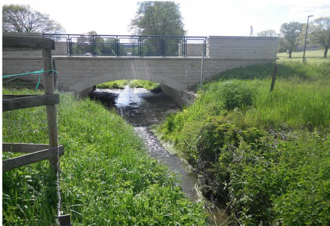
Foto gegen Fließrichtung
