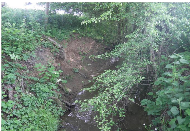
Foto gegen Fließrichtung
