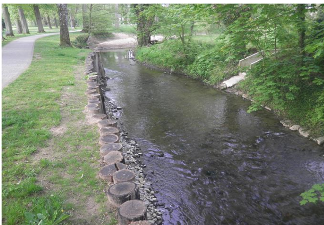
Foto gegen Fließrichtung
