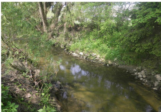
Foto gegen Fließrichtung
