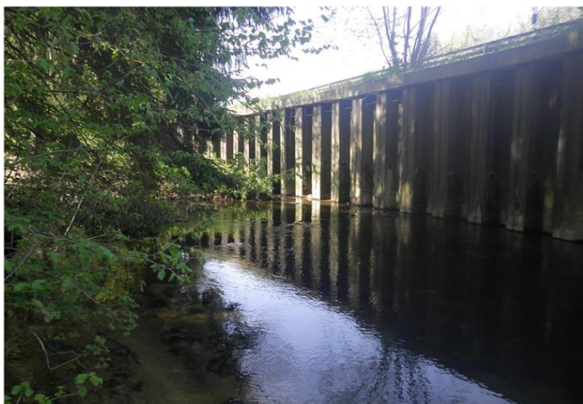
Foto gegen Fließrichtung
