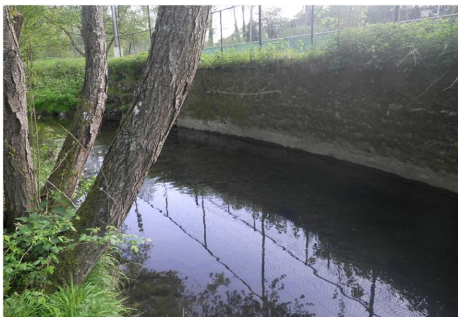
Foto gegen Fließrichtung
