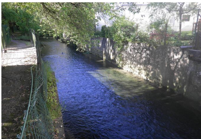
Foto gegen Fließrichtung
