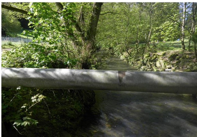
Foto gegen Fließrichtung
