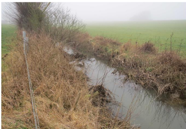
Foto gegen Fließrichtung
