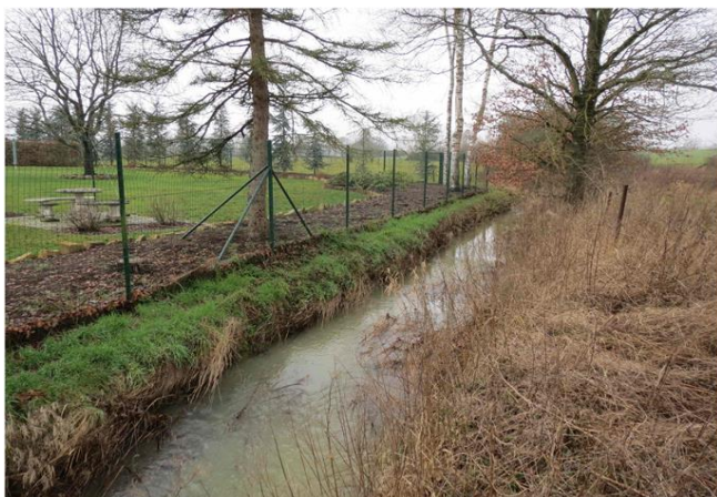
Foto gegen Fließrichtung
