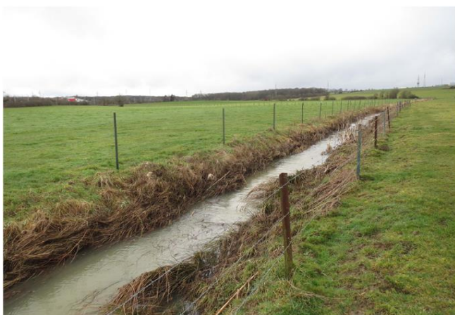
Foto gegen Fließrichtung
