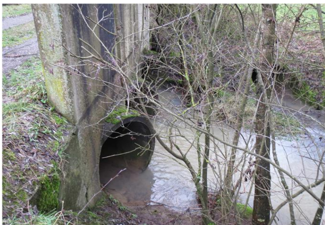
Foto gegen Fließrichtung
