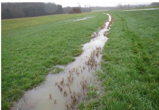
Foto gegen Fließrichtung
