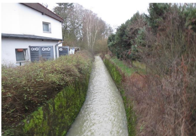
Foto gegen Fließrichtung
