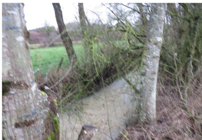
Foto gegen Fließrichtung
