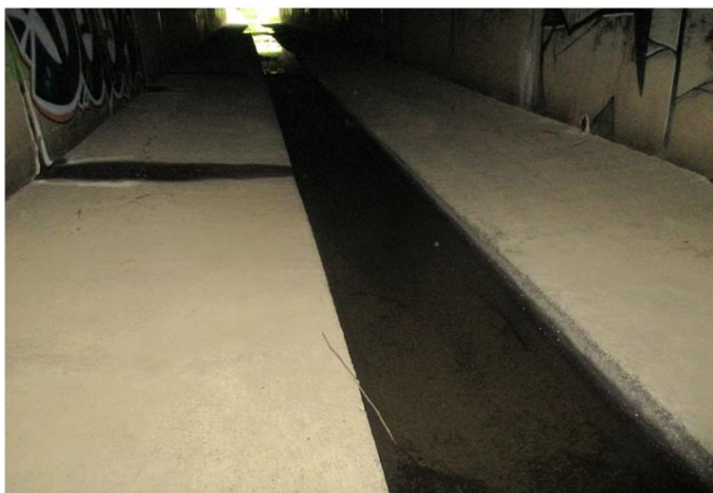
Foto gegen Fließrichtung
