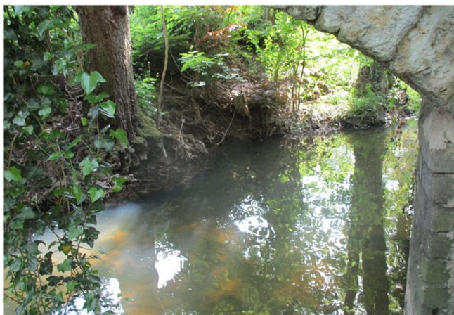
Foto gegen Fließrichtung
