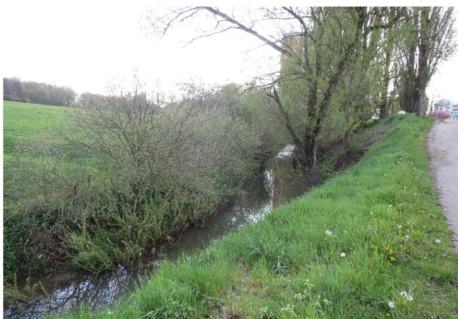
Foto gegen Fließrichtung
