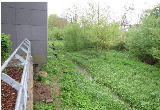
Foto gegen Fließrichtung
