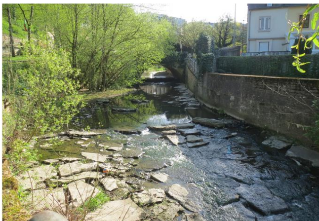
Foto gegen Fließrichtung
