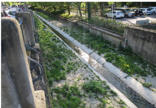
Foto gegen Fließrichtung
