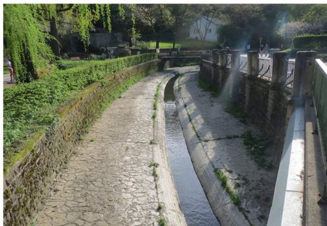
Foto gegen Fließrichtung
