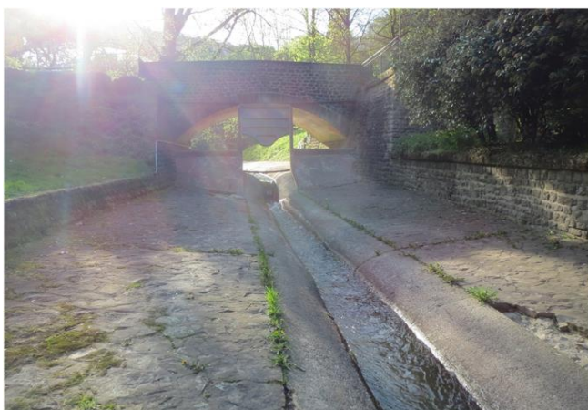
Foto gegen Fließrichtung
