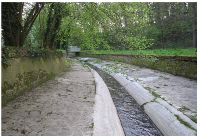
Foto gegen Fließrichtung
