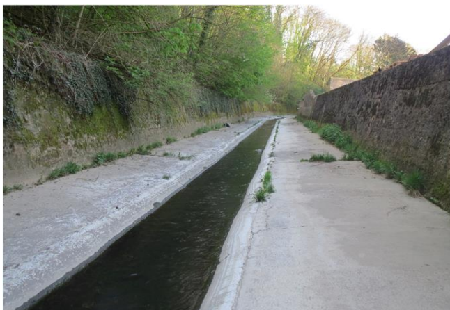
Foto gegen Fließrichtung
